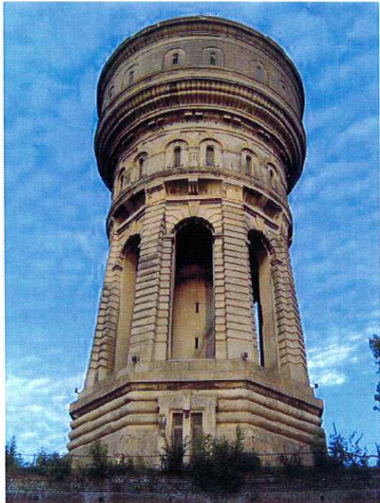
Château d'eau- Valenciennes
